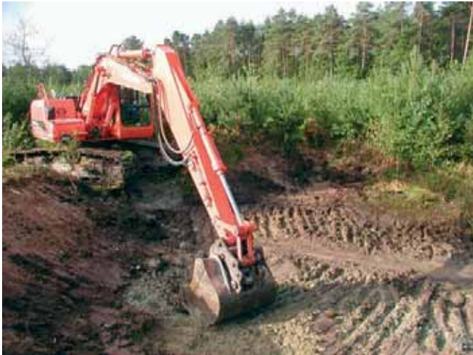
Restoration du milieu avec la pelle mécanique
