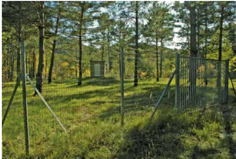
Périmètre de protection de captage immédiat (PPI) en forêt communale de Comps-sur-Artuby (Var)
