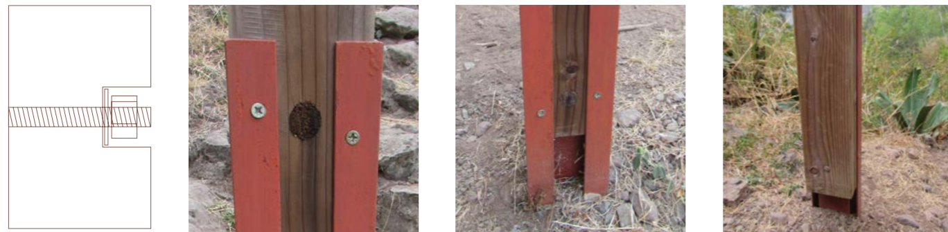
Boulon caché par un bouchon en bois
