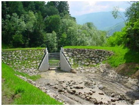
Illustration 206 : barrage filtrant, Verdun-sur-Ariège (Ariège).
