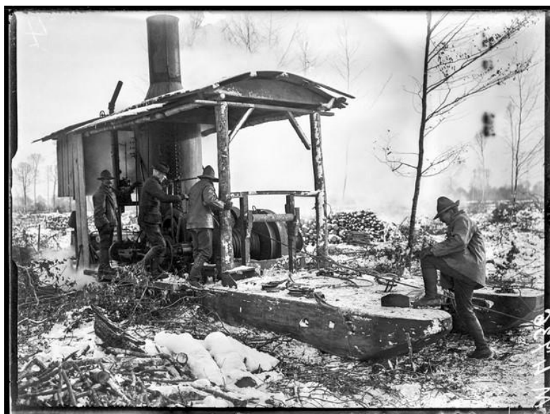
Illustration 22 : dans la forêt de Dreux, des bûcherons canadiens assurent l'exploitation du bois en 1916. Par un système de câble d'acier et de poulies, dans un rayon de 200m autour de l'engin, les troncs sont traînés jusqu'à une plateforme de stockage. © ECPAD.
