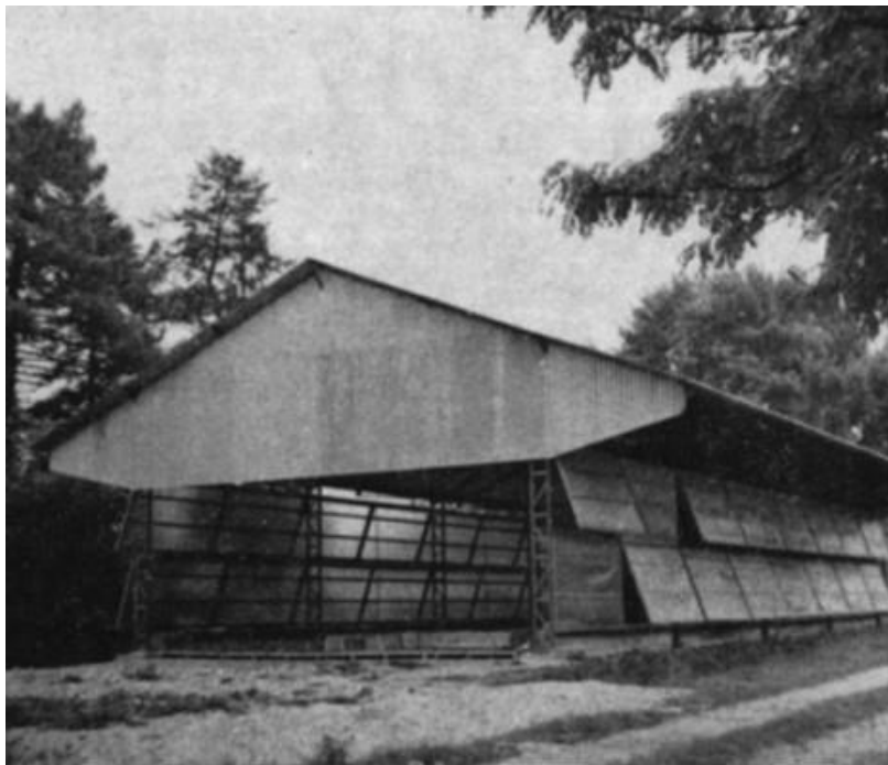
Illustration 127 : hangar de stockage de cônes aux Barres vers 1962 (extrait de la RFF).
