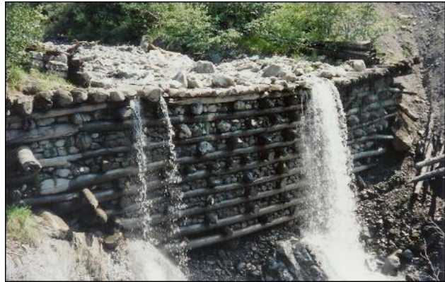
Illustration 199 : ancien seuil dans le torrent de l'Infernet. Forêt domaniale RTM du Boscodon (Hautes-Alpes).
