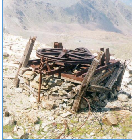
Illustration 72 : restes de pylônes et poulies (source : Spinelli et al., 2016).
