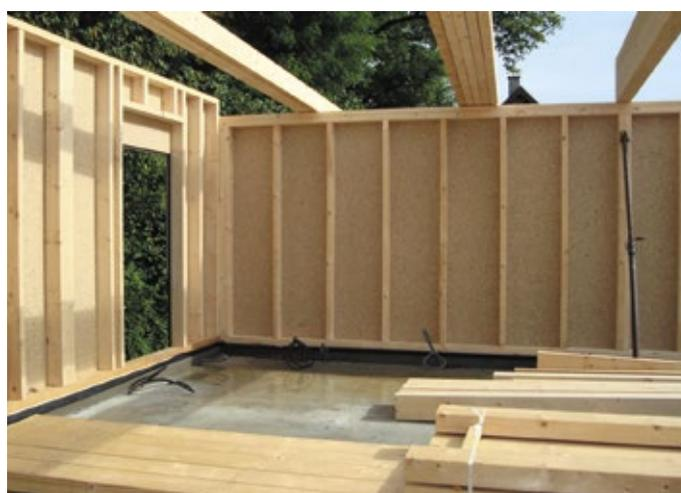
Figure 12 : mur ossature-bois avec panneaux d'OSB
