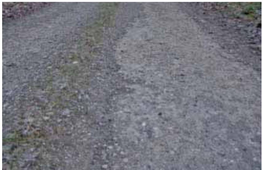
En 2005, sous la couche de roulement pelée, on distingue le corps de chaussée traité en 1992
