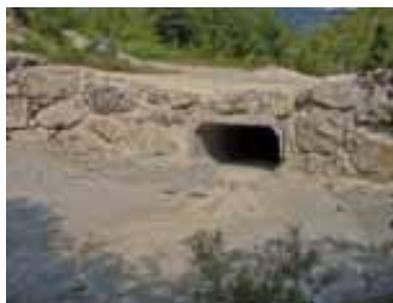
Pont cadre avec route en forme de berceau permettant le débordement en cas de dépassement de la crue de projet (FD RTM de Berre les Alpes - 06)
