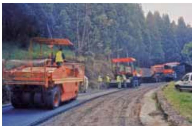
Atelier de mise en œuvre d'enrobés sur la route forestière du volcan (environ 300 000 véhicules/an)
