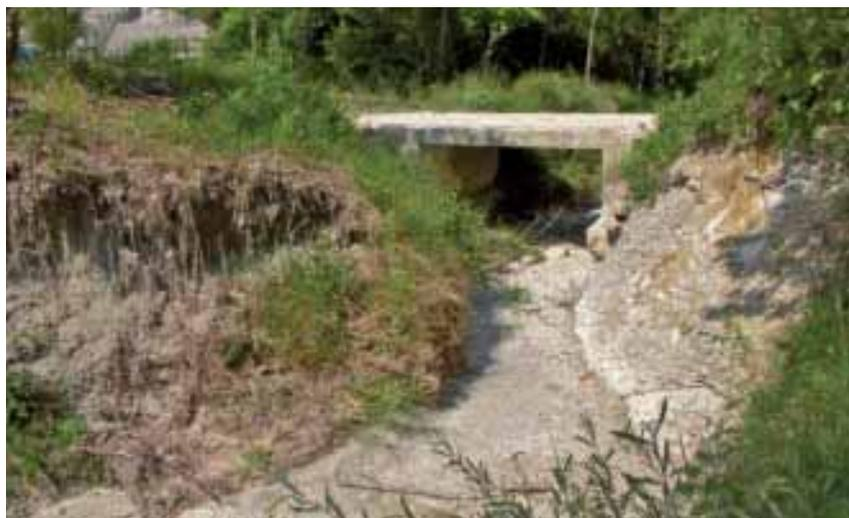
Ponceau désaxé par rapport au vallon, suite à un glissement de la berge en rive gauche. Le rétrécissement provoque l'accélération des écoulements et les fondations de l'ouvrage sont visibles. En amont (au premier plan), une anse d'érosion latérale se développe. (FD RTM de
