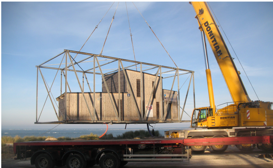
Déplacement du poste de secours du Petit Nice.
