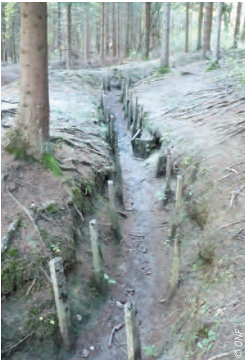
Maintien en état des sites de mémoire Protection contre l'érosion des boyaux (ONF)
