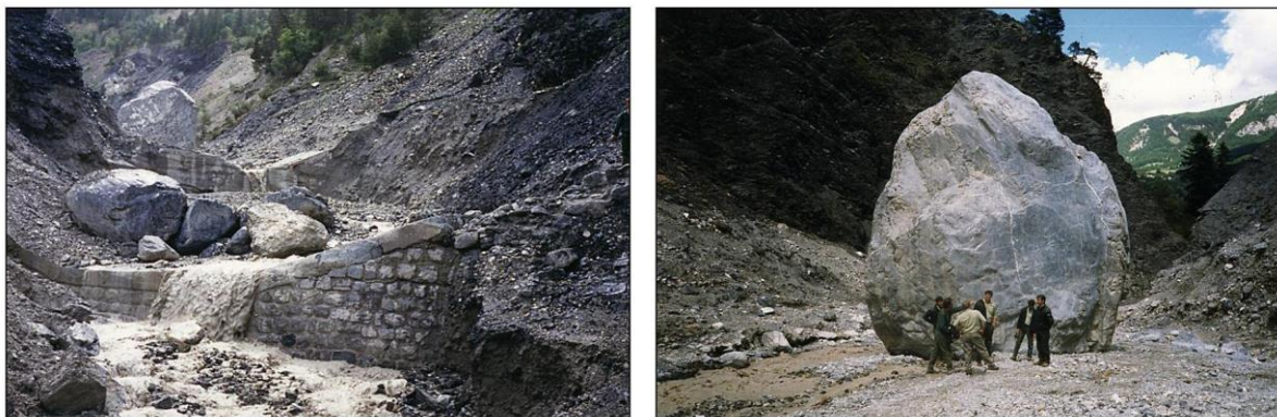
Photo 6 : Matériaux charriés par la crue de 1998. Sur la photo de droite, un bloc de 600 tonnes (250 m 3 ) a été déplacé par la crue, ce qui démontre bien la force des phénomènes torrentiels du Boscodon (source : RTM)
