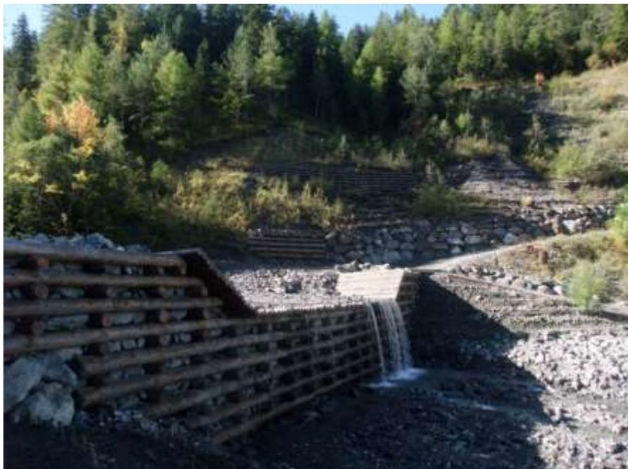
Photo 24 : Le barrage B1377, l'un des plus importants ouvrages bois en France, construit en 2011
