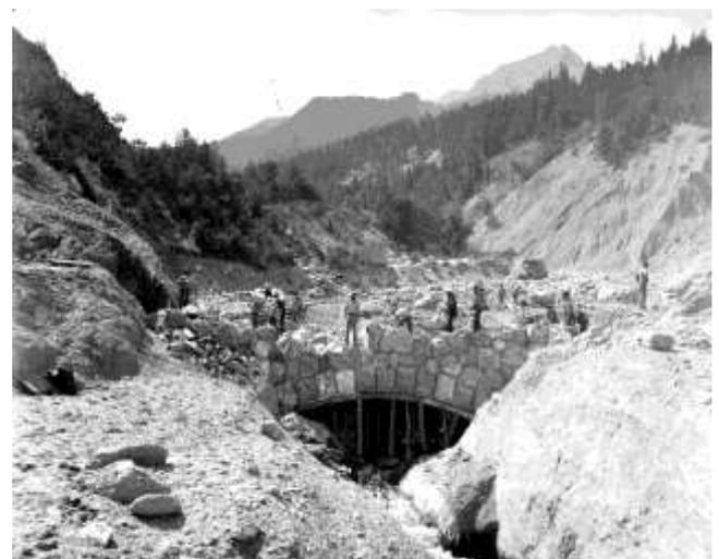
Photo 11 : Torrent de Boscodon, construction du grand barrage de l'abbaye. 1894 (Fonds RTM)
