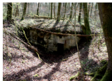
Abri souterrain © Rémi De matos-Machado
