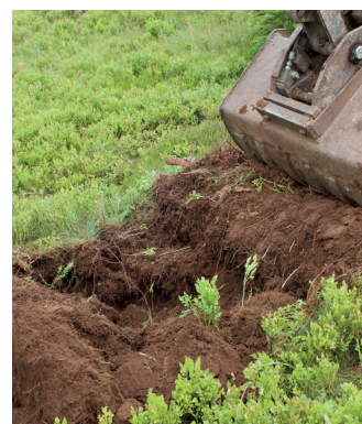
Décompactage du sol
