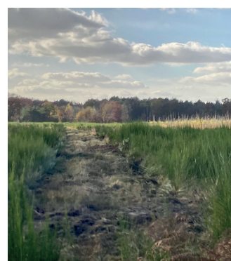
Broyage des bandes de 4 mètres qui accueilleront les plants
