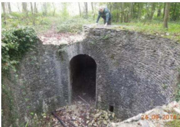
*Vue du haut de la tour : le parapet a été démonté sur environ 1 mètre de long au-dessus de l'arrivée du passage voûté.*
